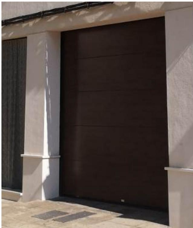
1.6 Puerta seccional, lamas metálicas horizontales.
