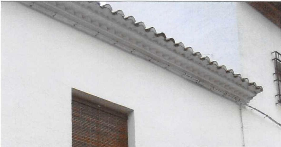
Imagen nº 8. Alero triple: tejado volado sobre hilada continua de ladrillos apoyada en otra de ladrillos a testa girados 45° con remate inferior rasilla).
