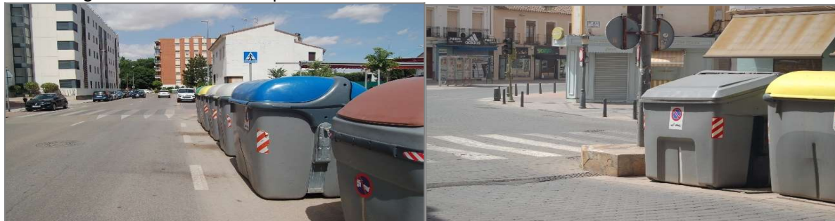
Imagen 40: Contenedores que obstaculizan la visión.
