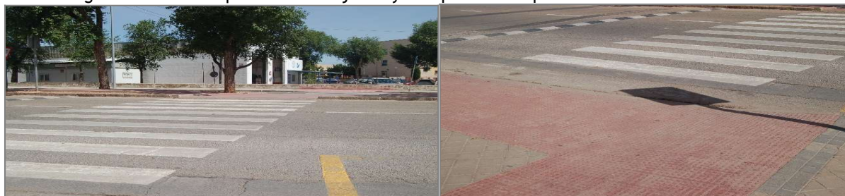
Imagen 38: Pasos de peatones rebajados y con pavimento podotáctil.
