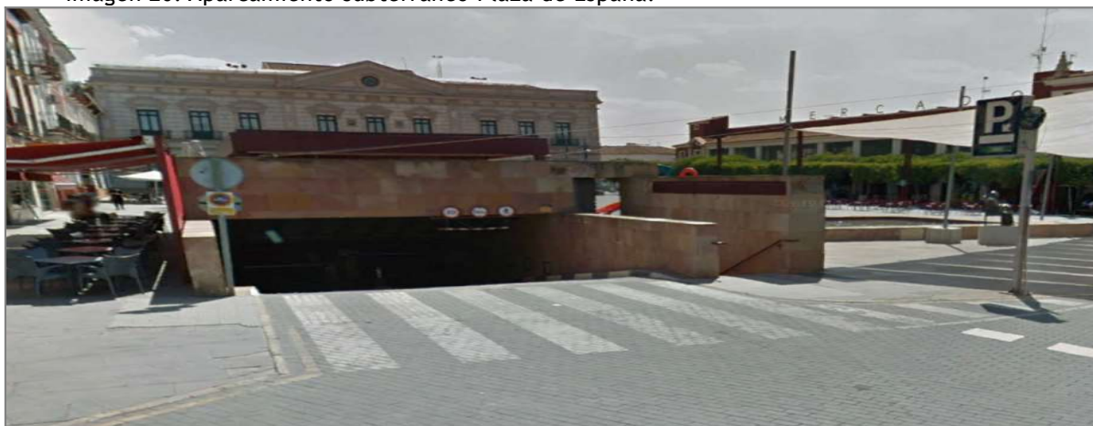
Imagen 20: Aparcamiento subterráneo Plaza de España.
