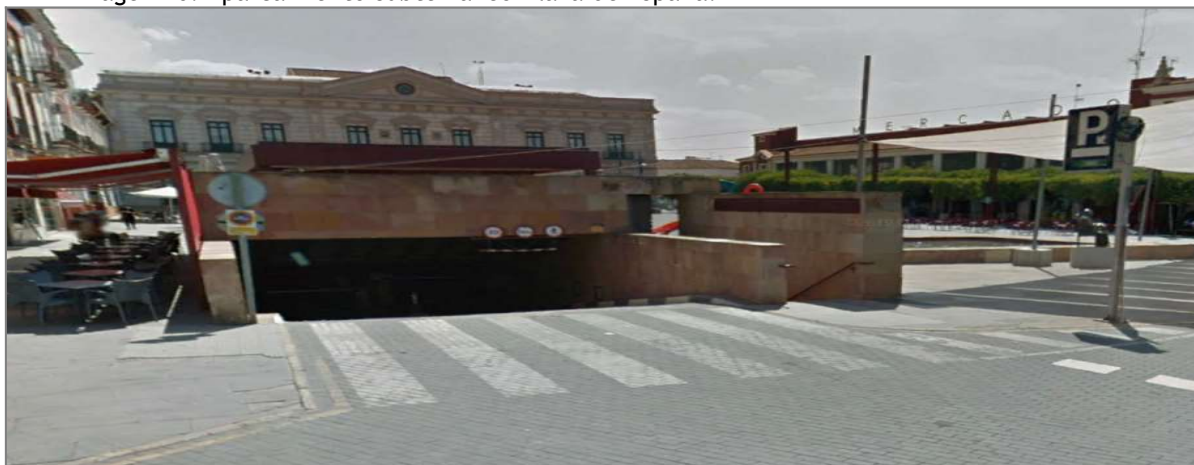
Imagen 20: Aparcamiento subterráneo Plaza de España.
